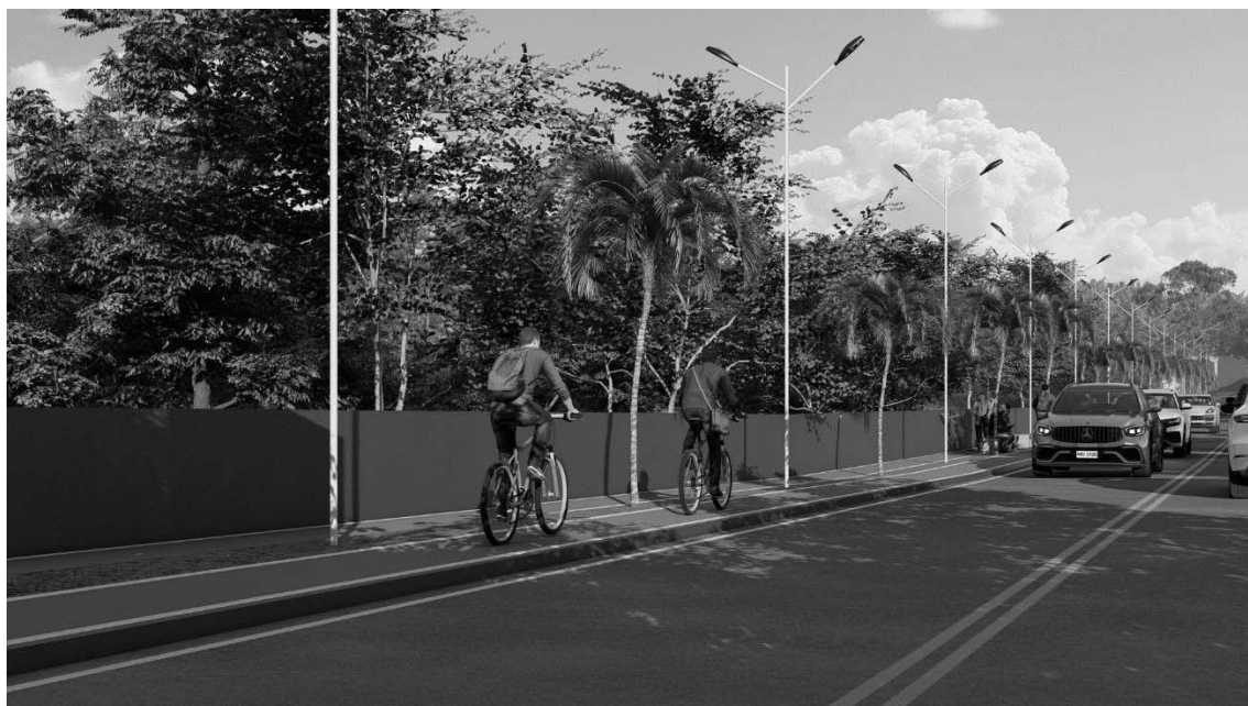
Figura 5 - Trecho da ciclovia com mureta de proteção executada sob contenção em pedra argamassada.
